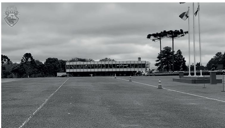
Figuras 20 e 21. Prédio do Refeitório da APMG
