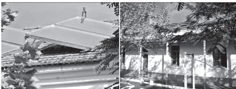
Figuras 17 e 18: Aquecimento solar da água em alojamentos na 13ª Companhia de Comunicações Mecanizada, São Gabriel, RS
