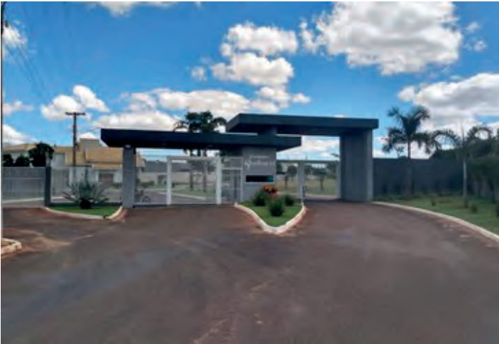
Figura 1. Nova Andradina- MS. Vista da entrada do residencial Boulevard
