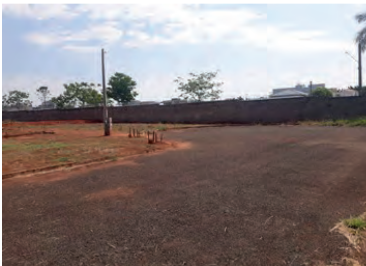
Figura 2. Nova Andradina- MS. Muro demarcando o residencial Boulevard
