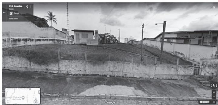
Figura 3. Estação Meteorológica situada na Rua Ernestina, s/nº, sob jurisdição do INMET
